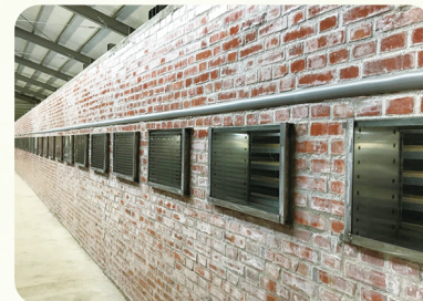
杭菊隧道式乾燥間
